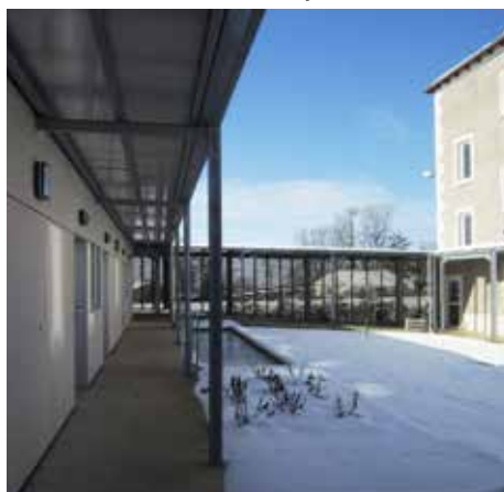
les coursives : côté patio (studio niveau 1)
